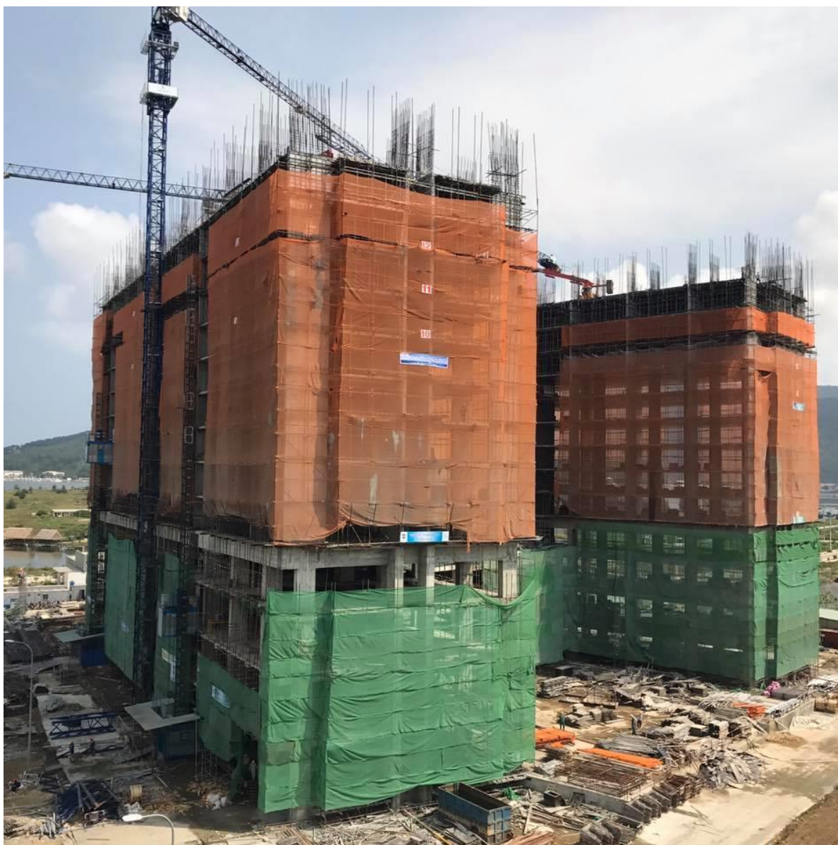
HÌNH ẢNH CÔNG TRÌNH ĐANG THI CÔNG (THÁNG 3-2017)
