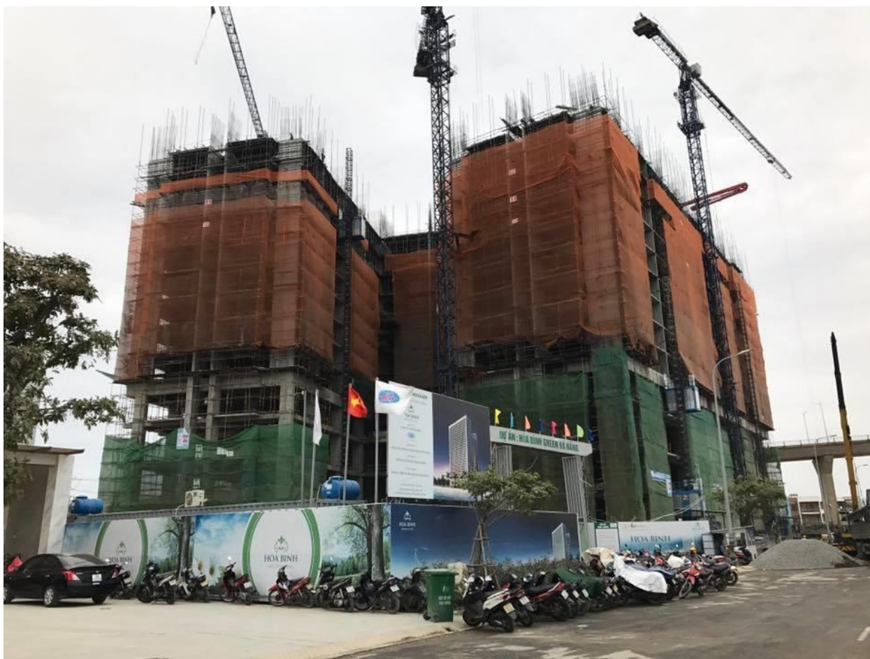
HÌNH ẢNH CÔNG TRÌNH ĐANG THI CÔNG (THÁNG 3-2017)
